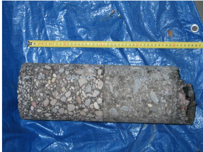
Rysunek 2.19 Rdzeń W2_B_S pobrany w miejscu pozbawionym spękań i nie wskazującym na obecność odspojień lub innych osobliwości budowy nawierzchni na odcinku B_S (DK 7, Cedry Małe). Reprezentuje on typową, zdrową nawierzchnię tego odcinka. Dobrze widoczne nowe warstwy asfaltowe, podbudowa MCE, a pod nią relikty dawnej nawierzchni zaczynający się warstwą ścierną i wiążącą.
